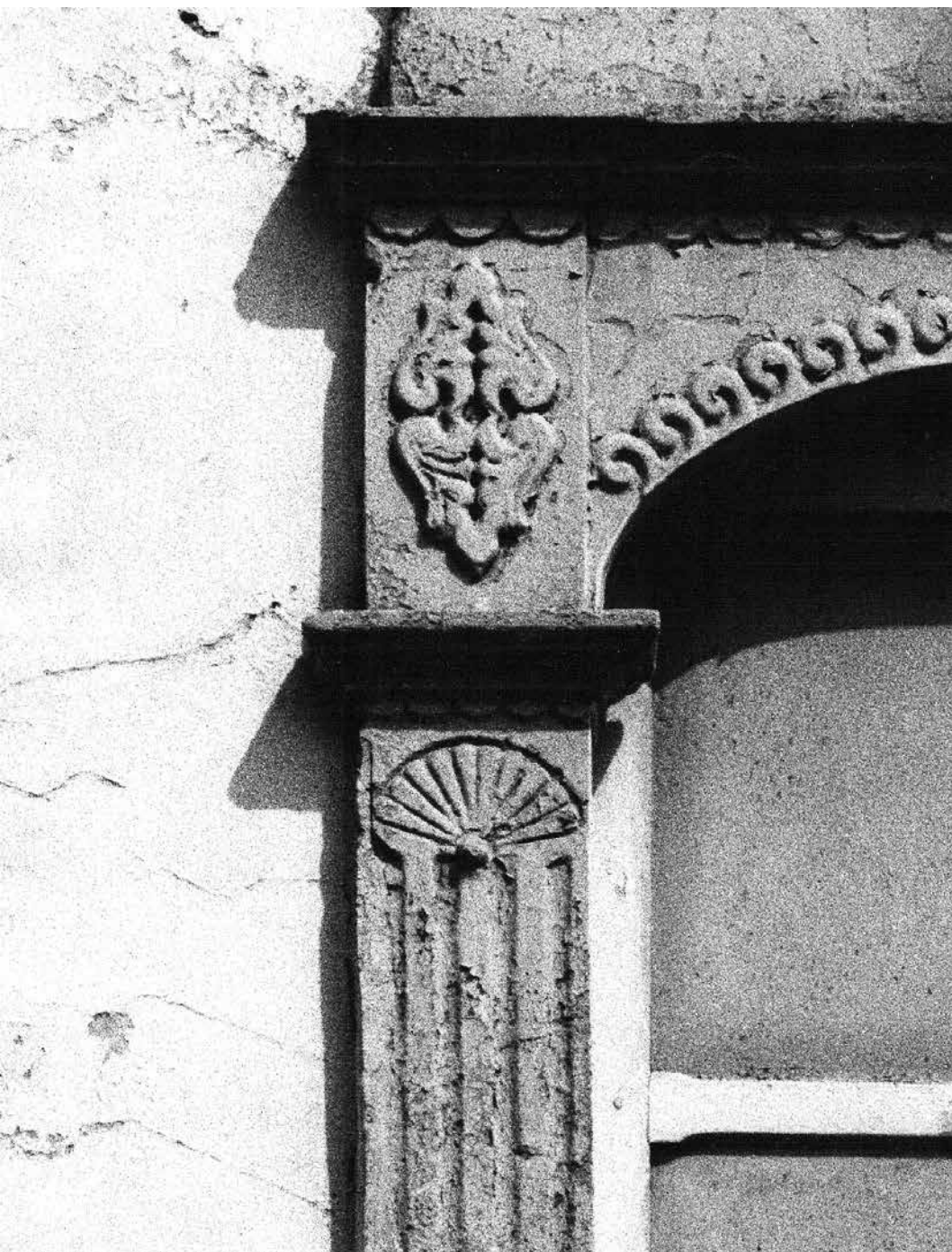
51. CAPITEL DE PILASTRA. Detalle de fachada en vivienda tradicional. Casco histórico de Maracaibo. Estado Zulia. 1986
