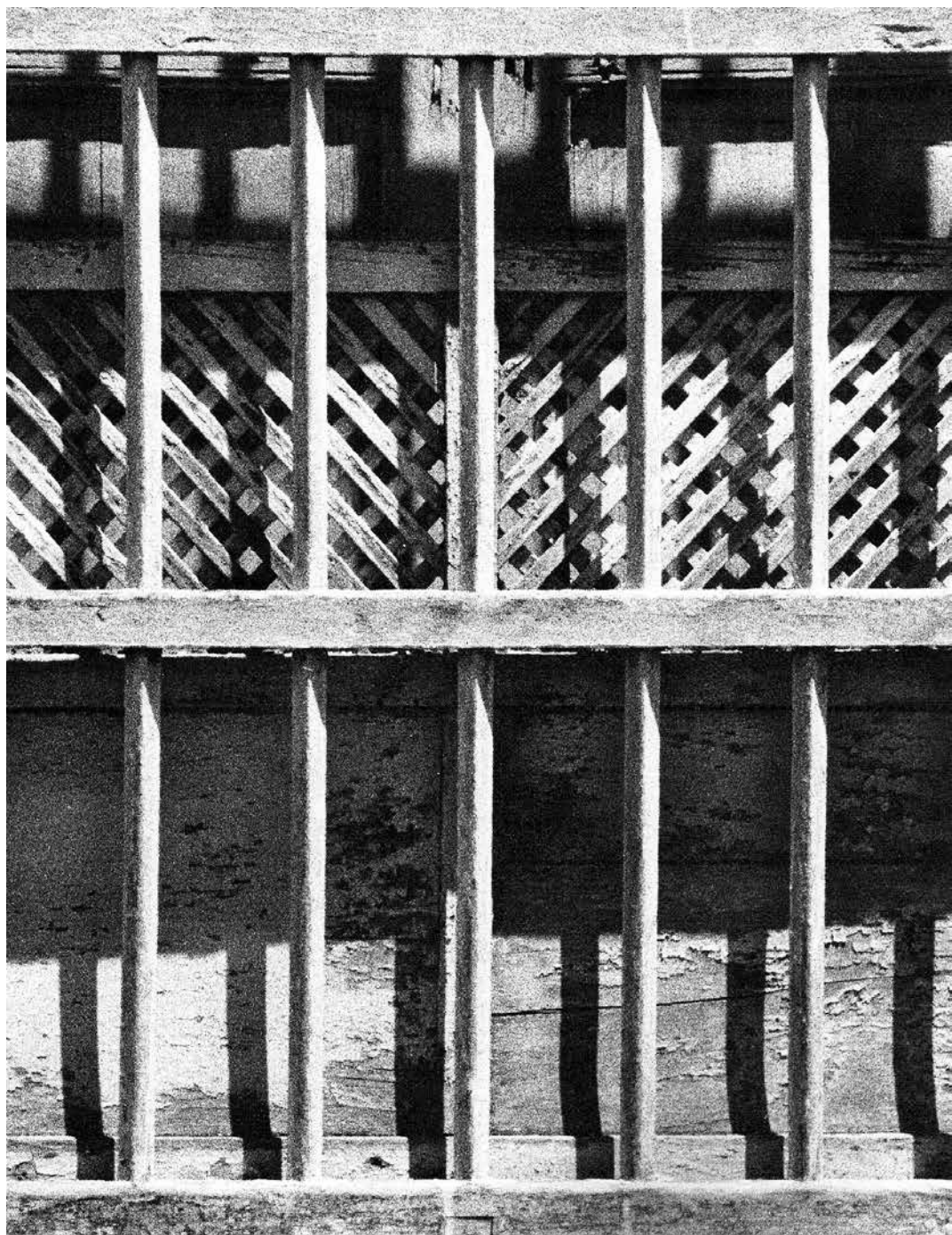
52. BALAUSTRES Y MANPARA. Detalle de ventana en vivienda tradicional. Casco histórico de Maracaibo. Estado Zulia. 1985
