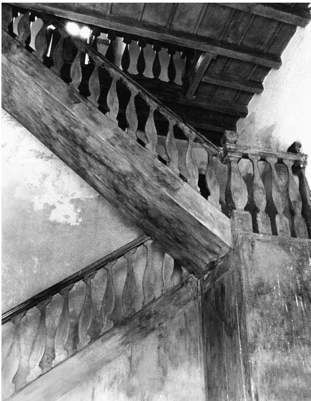
126. LA ESCALA DE MADERA. Espacio interior de vivienda colonial. Zona colonial de Puerto Cabello. Estado Carabobo. 2003
