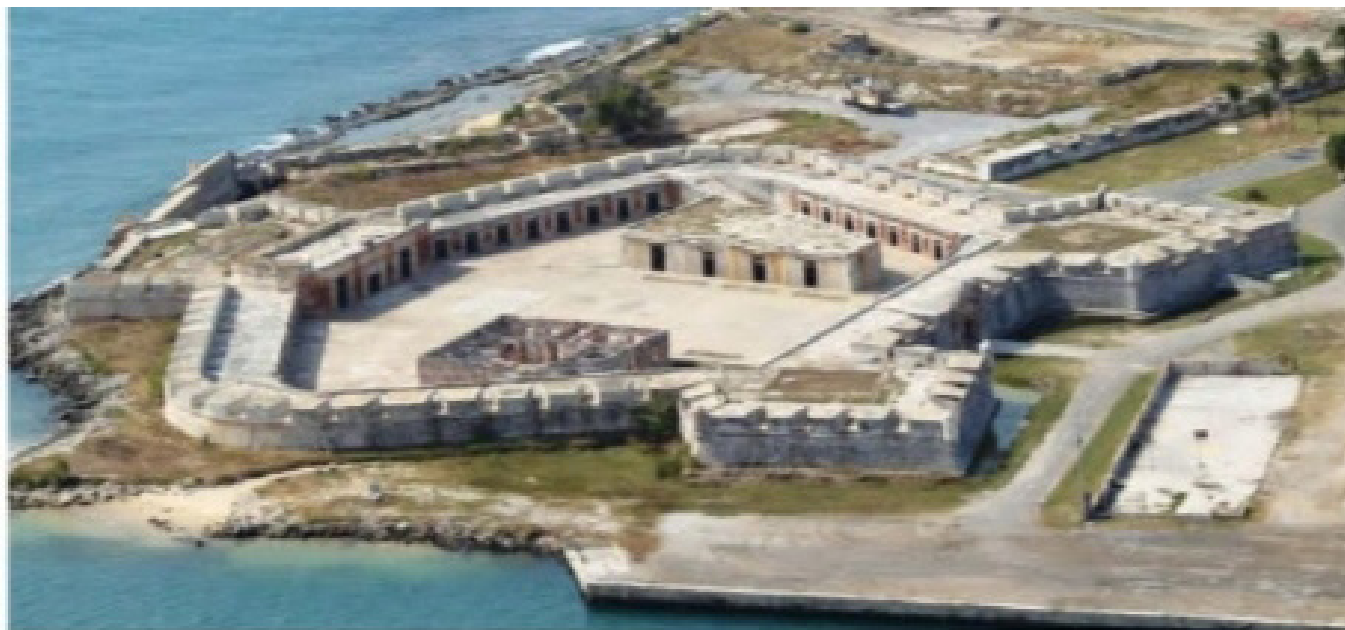
Vista del Castillo Libertador de Puerto Cabello, en donde fue privado de libertad el ilustre cojedeño Ángel María Garrido, por la dictadura de Juan Vicente Gómez.
